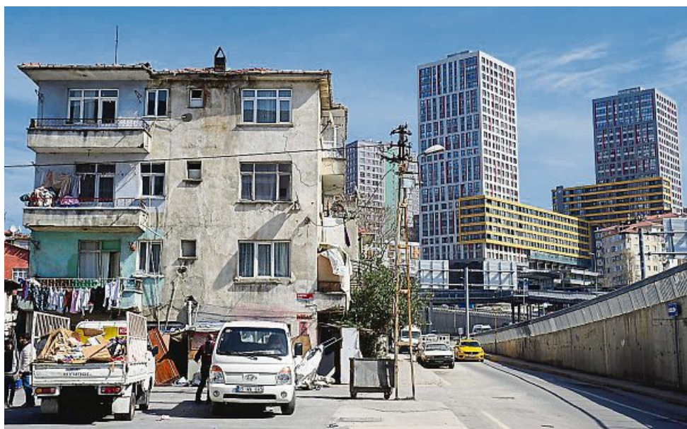
Baufällig neben hochmodern: Rund 1,5 Millionen Häuser in Istanbul gelten als „riskant“, also im Falle eines schweren Erdbebens einsturzgefährdet.
